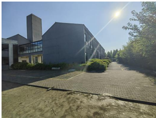
项目拟建址西侧
