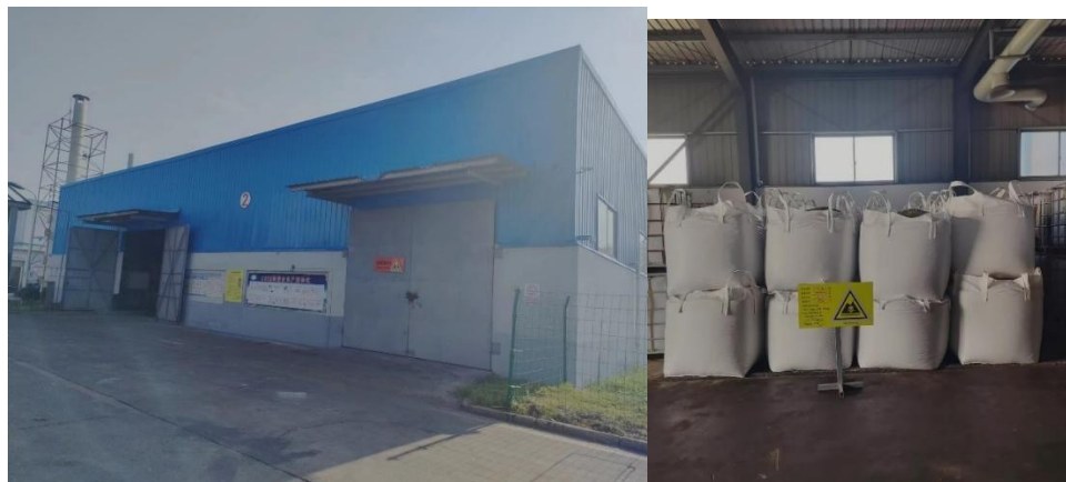
图 3.2-7 危废暂存仓库
